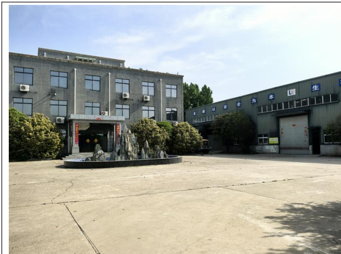
项目场地内办公楼及场地现状
